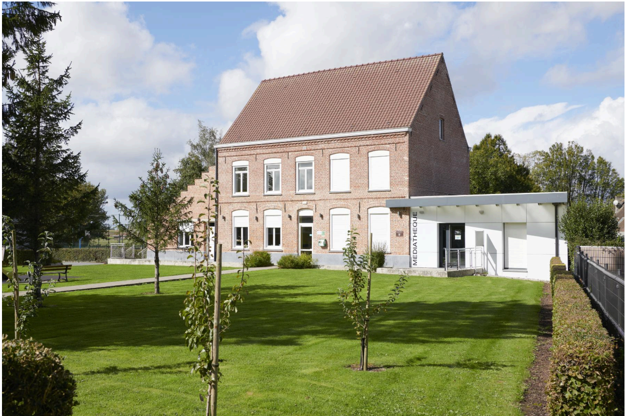
Vue de la façade depuis le nord.
