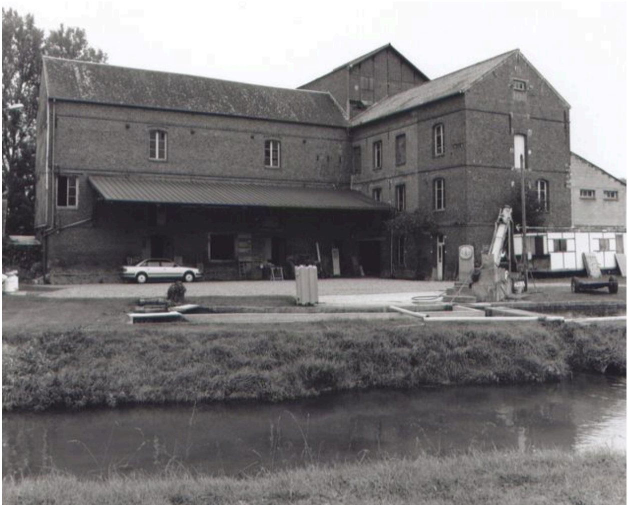
Ensemble sur cour de la minoterie.
