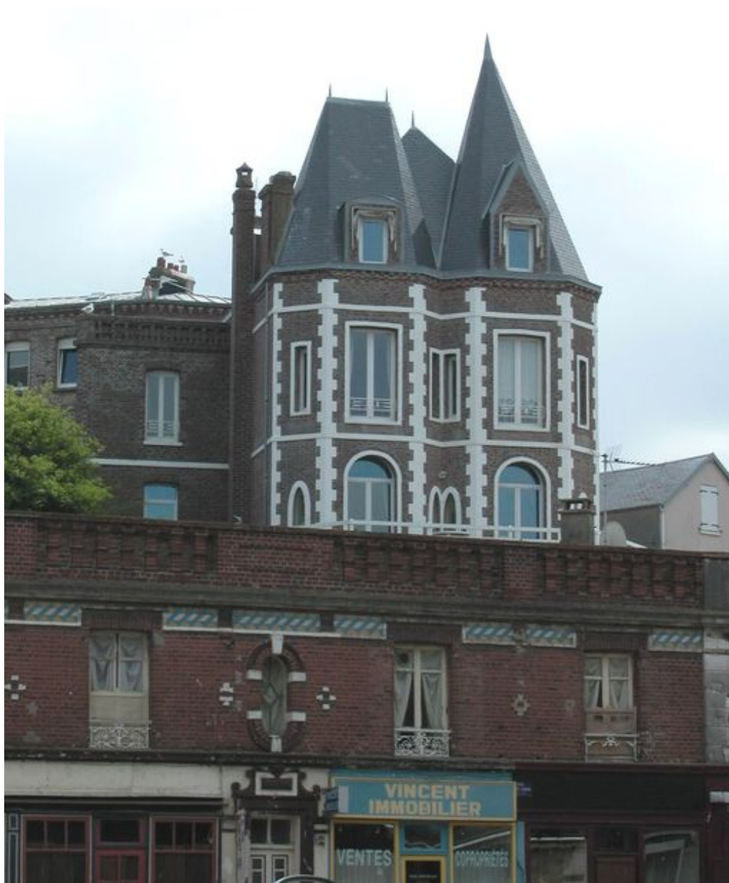
Vue d'ensemble depuis la rue Raspail.
