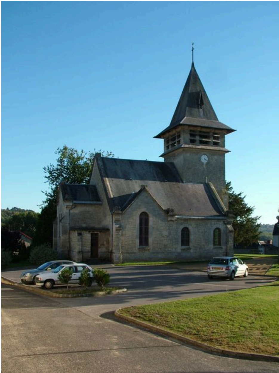
Vue générale depuis le nord.
