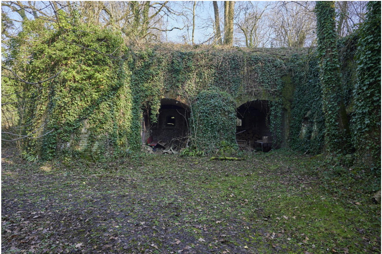
Aile ouest. Vue extérieure de la caponnière simple.
