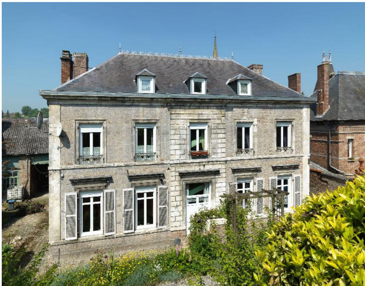
Façade postérieure, vue de face.
