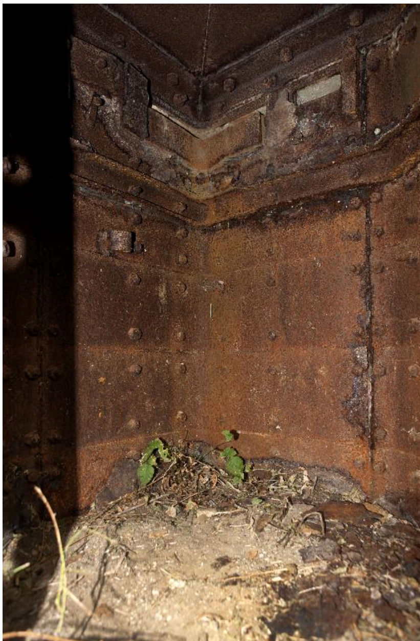
Observatoire casematé, vue intérieure
