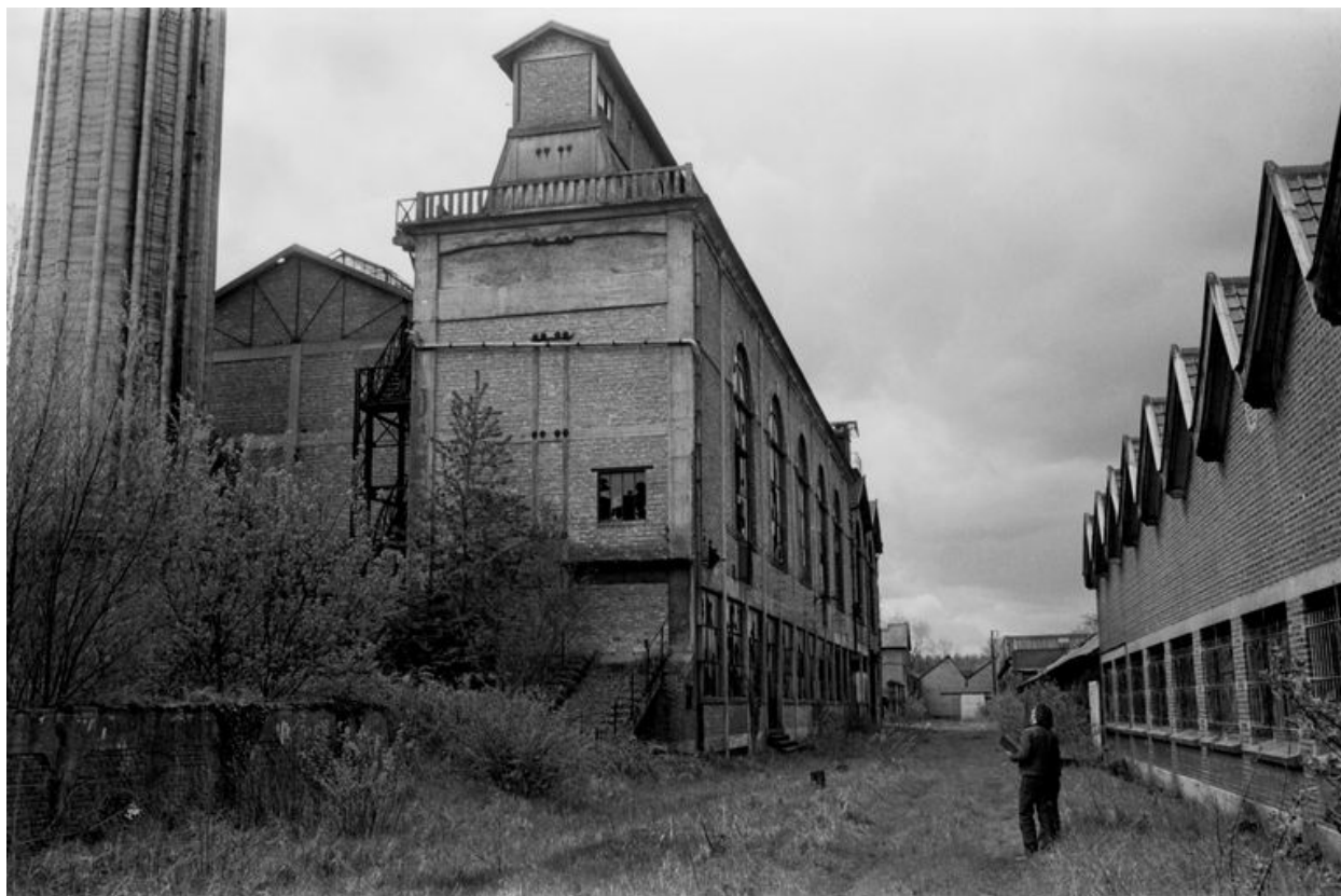
Centrale thermique, en 1983 : flanc nord-est (Ecomusée du Beauvaisis).
