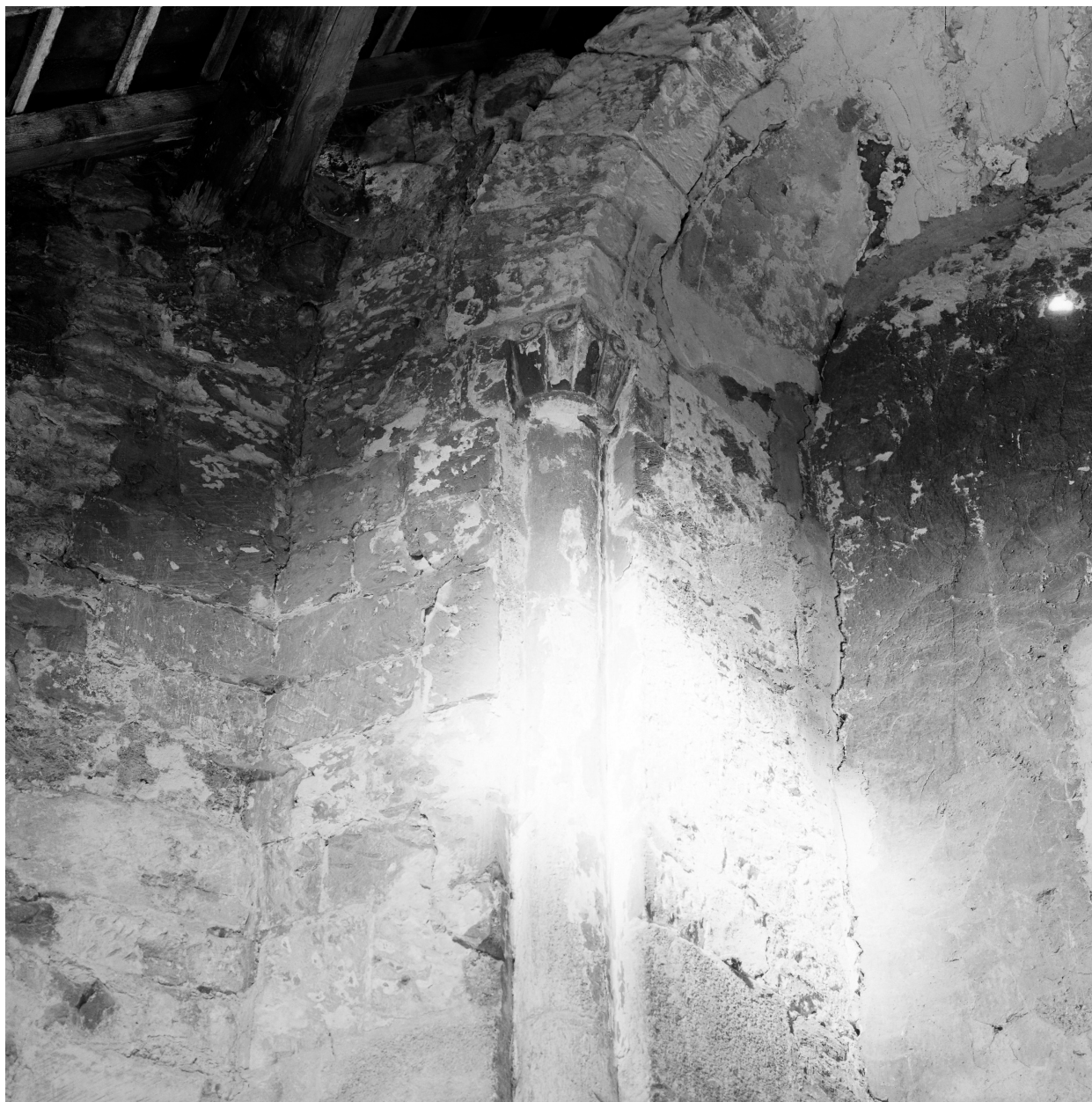
Bâtiment dans la cour, entrée 5 rue Henry, abside, pan nord, chapiteau nord.
