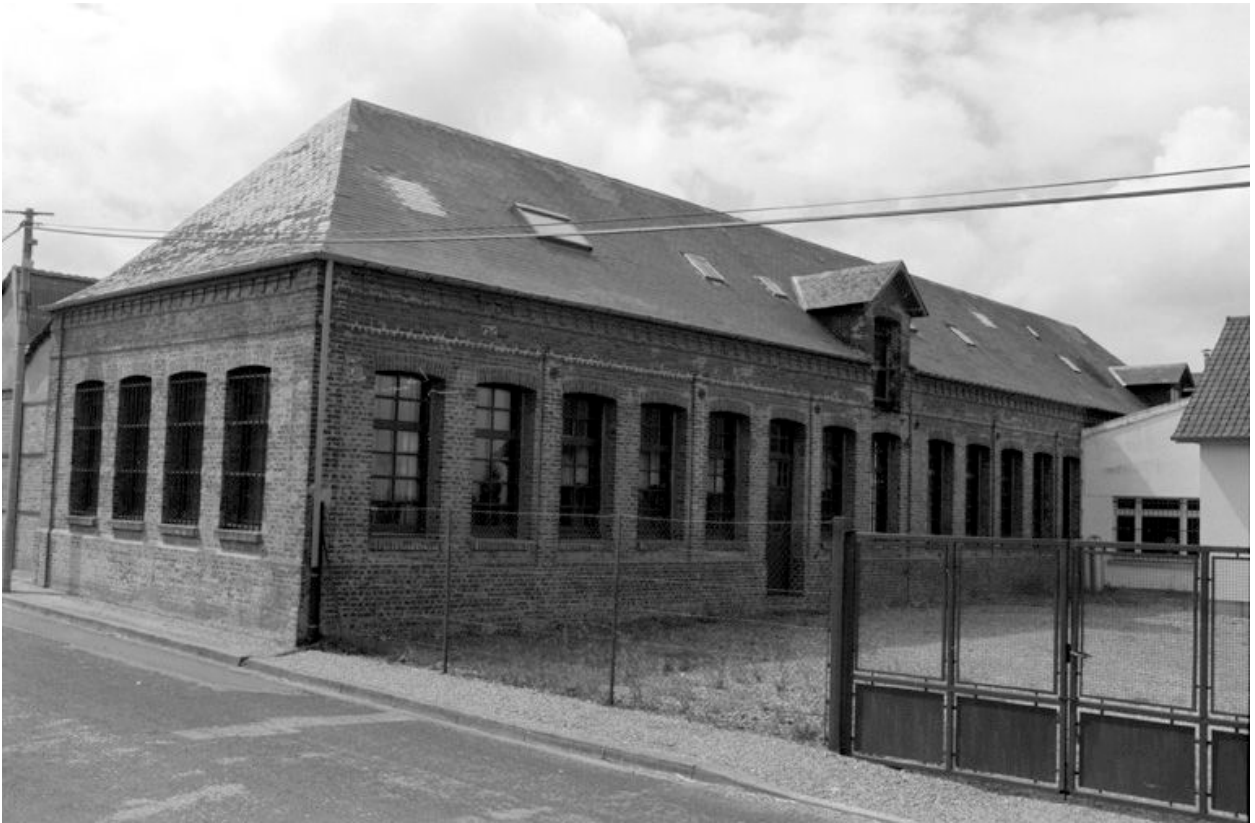
Atelier de fabrication, flanc nord.
