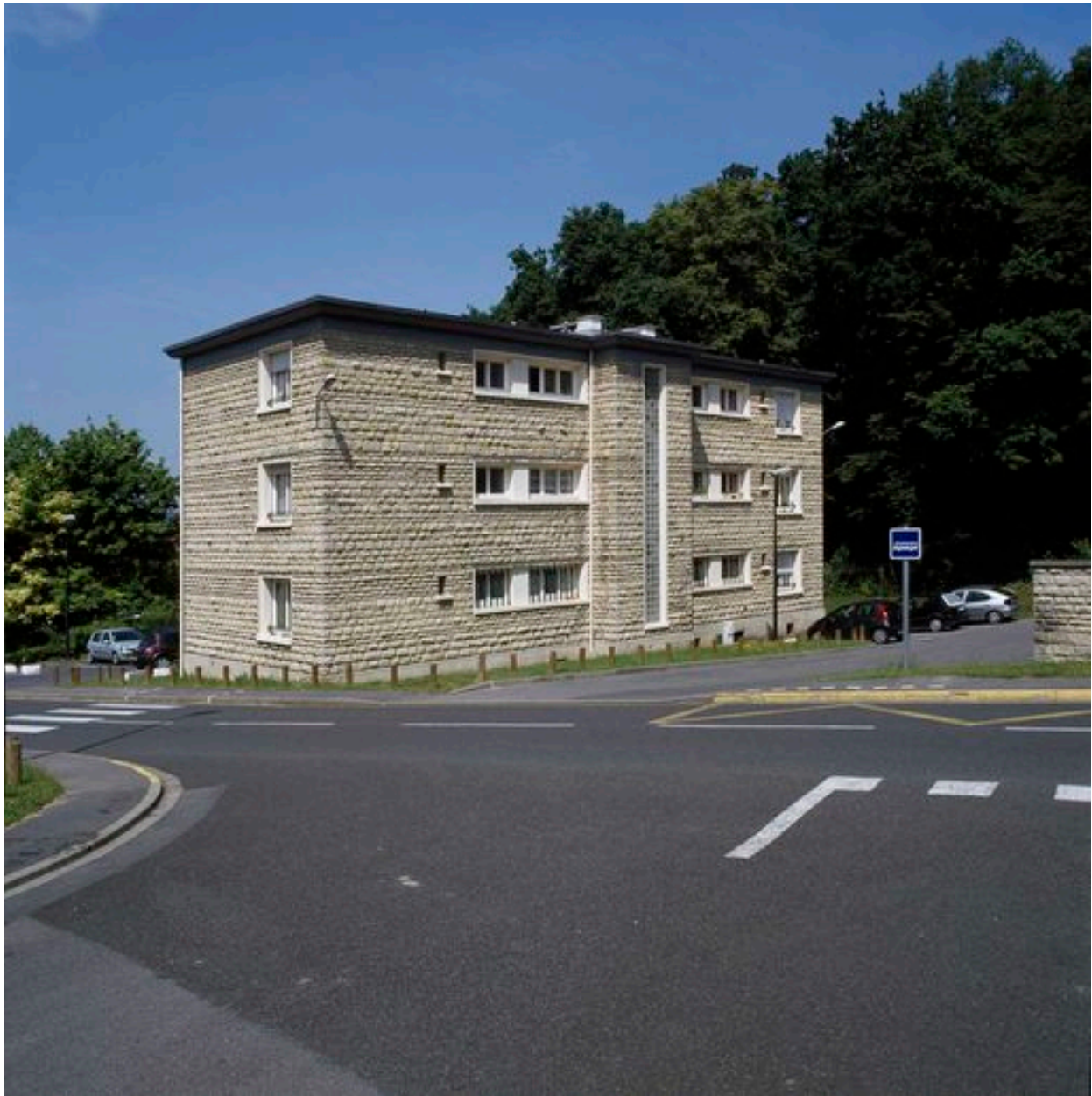
Élévation postérieure d'un immeuble de logements pour employés.
