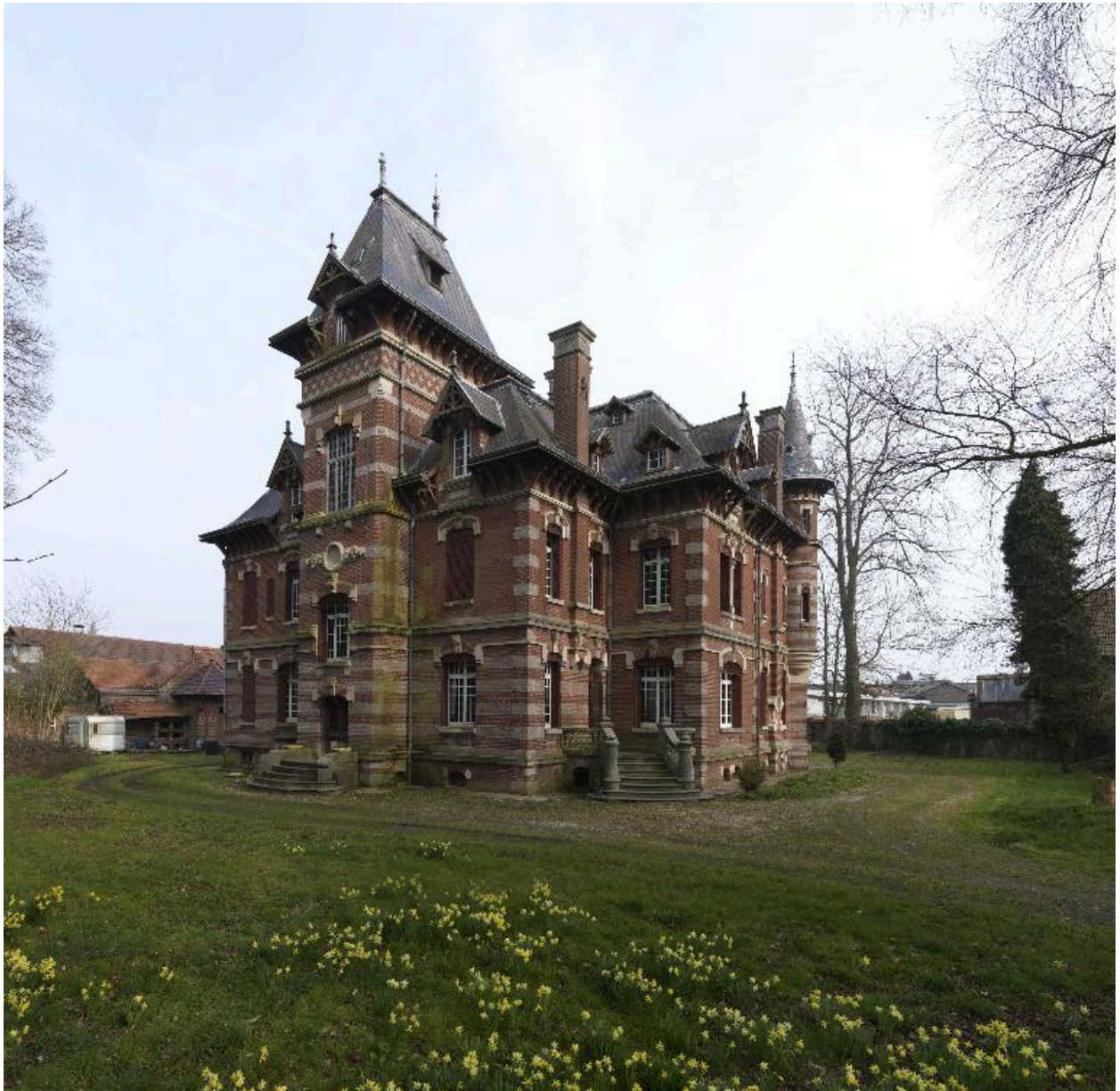
Vue de trois-quarts nord-ouest.
