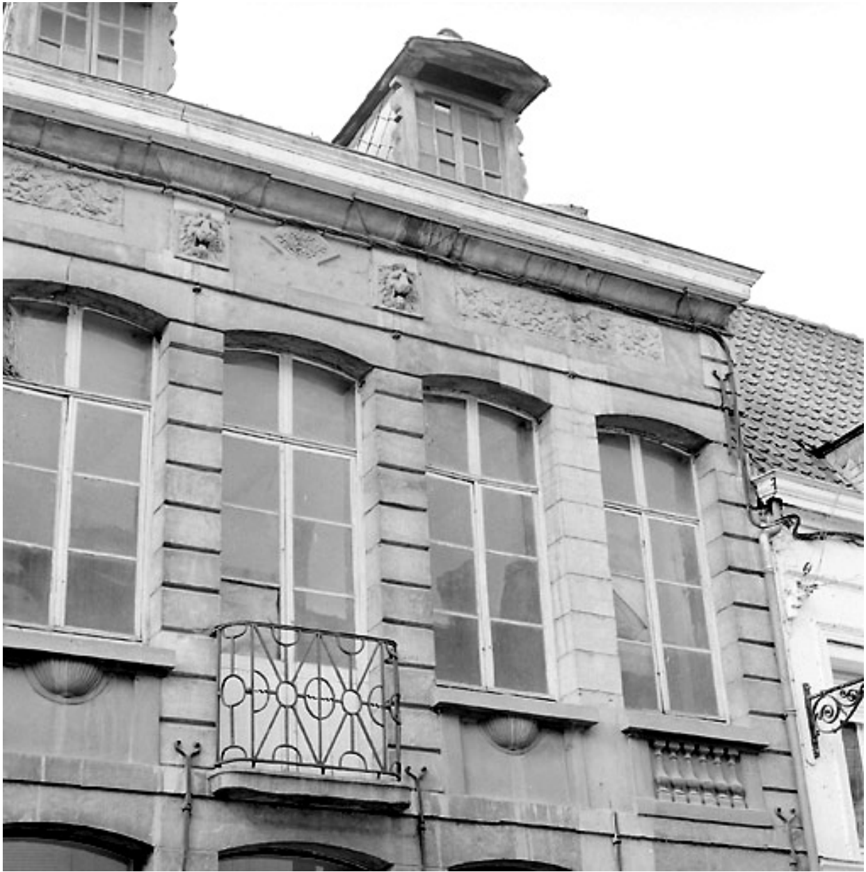
Façade, étage, vue partielle.
