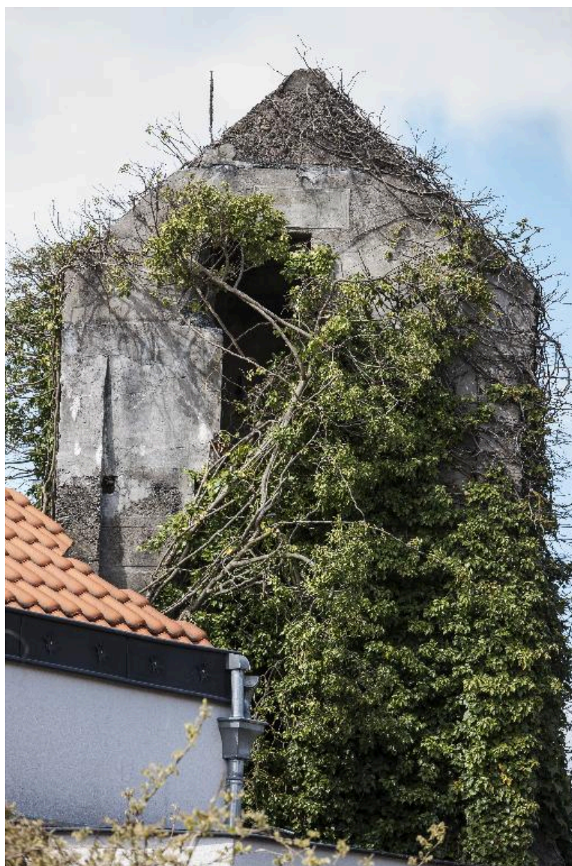
Tour casematée depuis la rue
