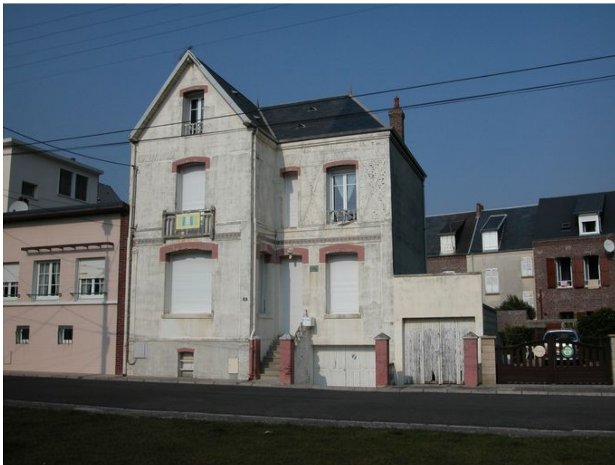
Aménagement tardif d'un garage en soubassement.
