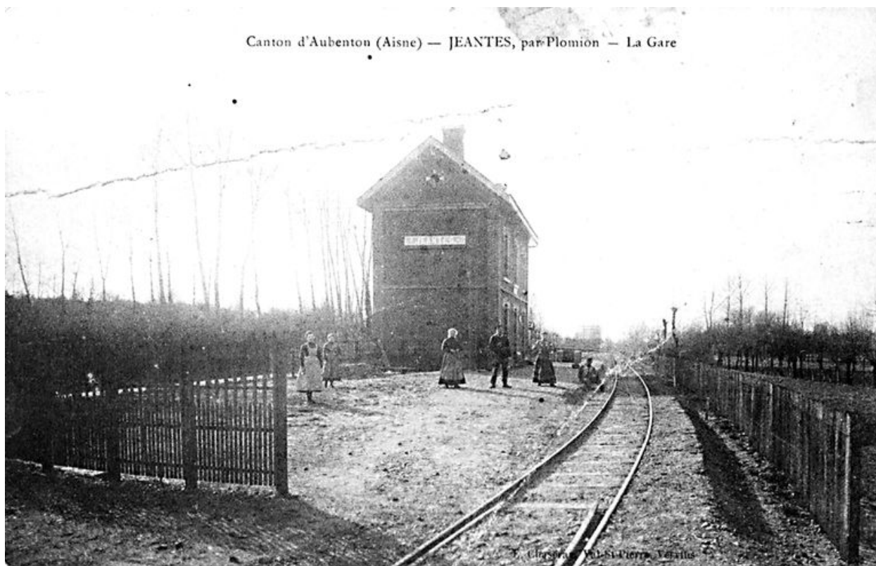
Vue ancienne de la gare (AP).
