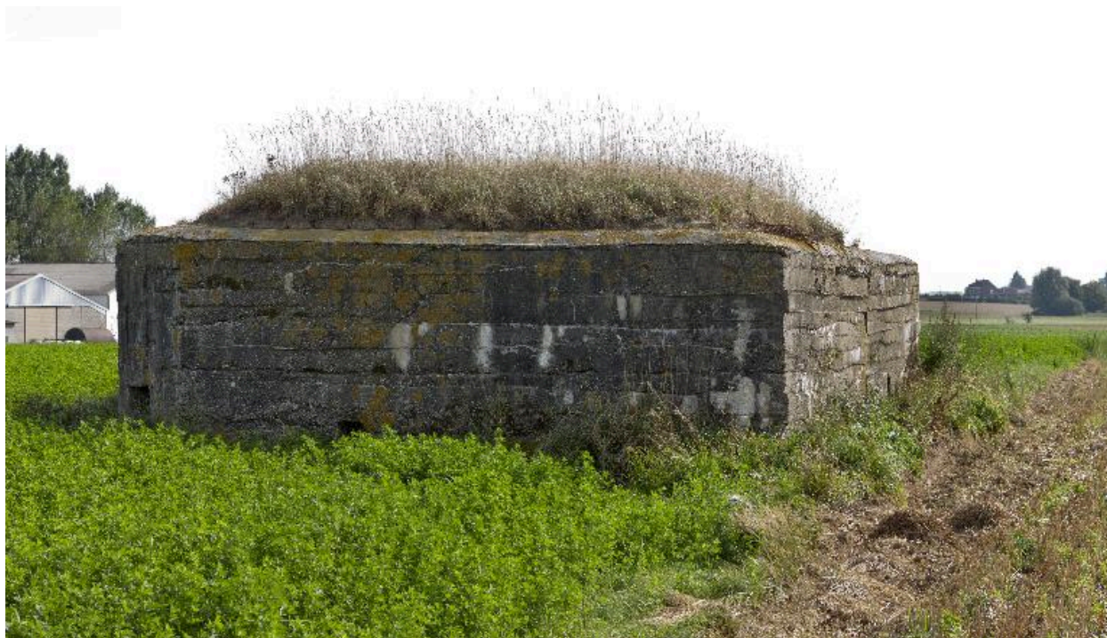
Vue latérale nord, vers le sud-ouest
