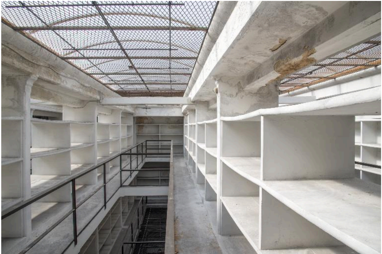
Bâtiment du dépôt, troisième étage : vue du vaisseau 2 vers l'ouest.
