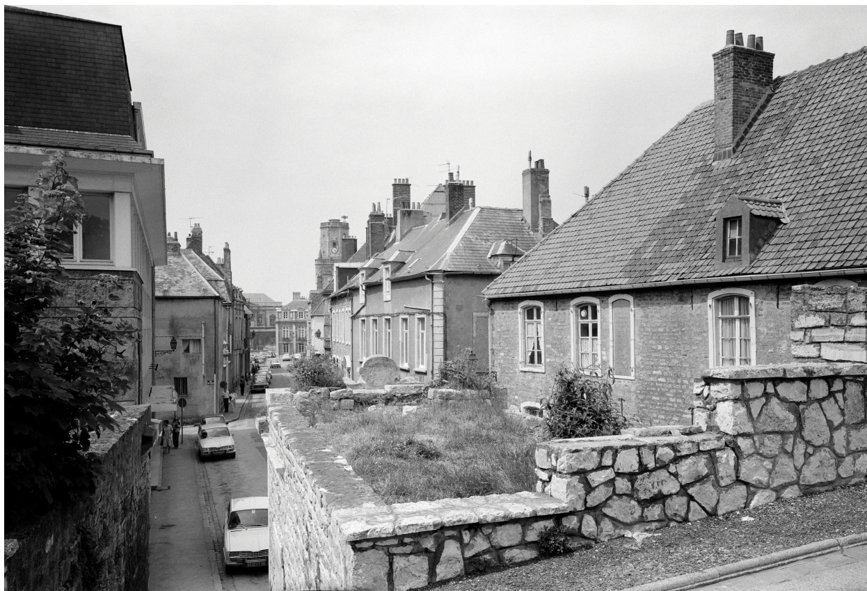
Arrières, vue du rempart.
