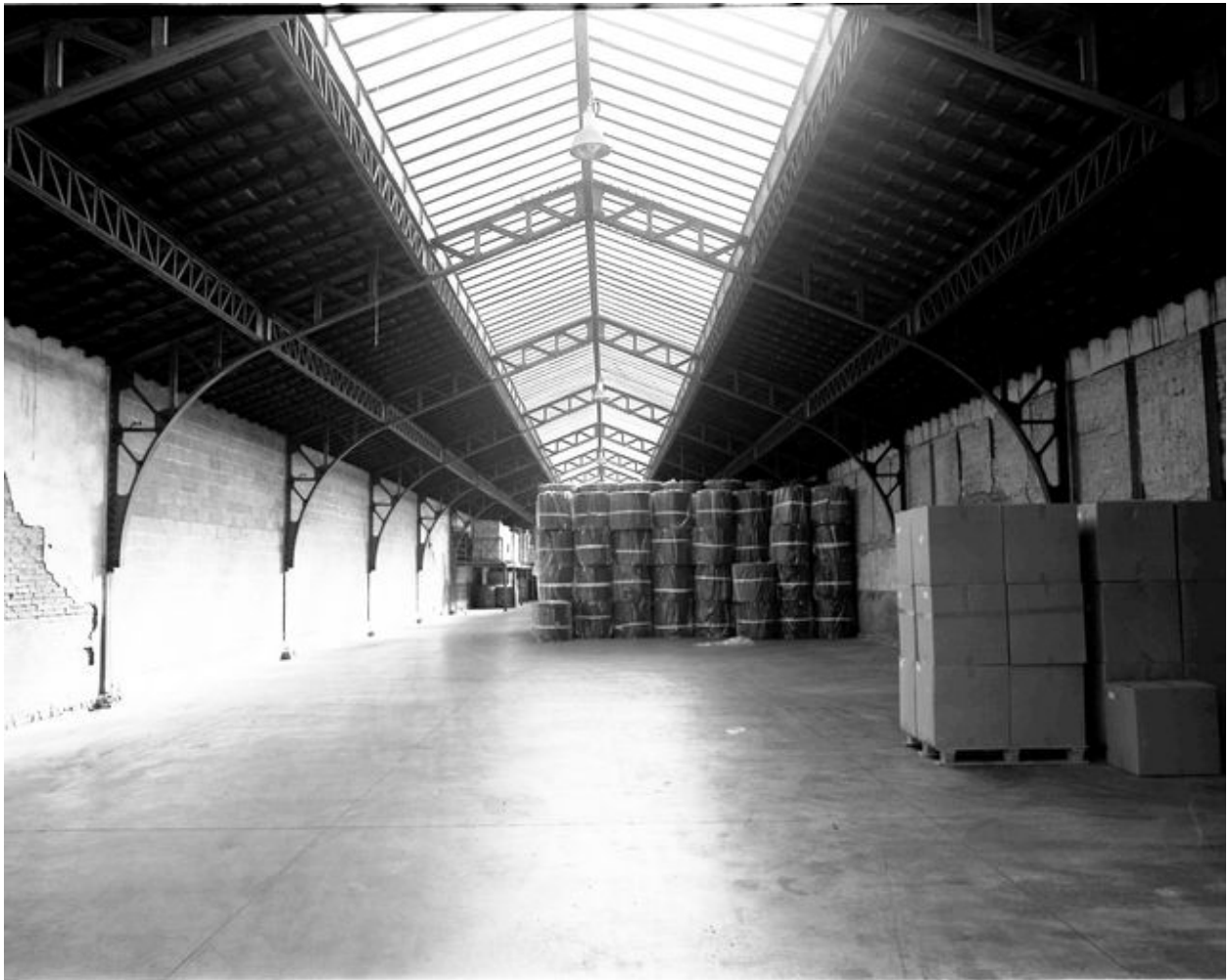
Intérieur du magasin industriel.
