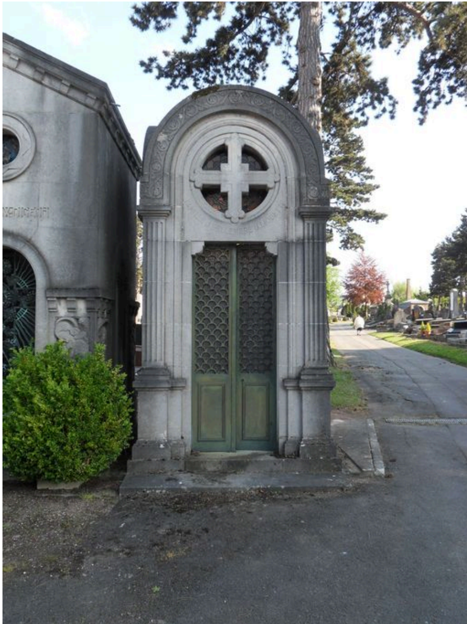
Tombeau (chapelle), vers 1930. Tende (architecte). Amiens, Vieux Saint-Acheul.
