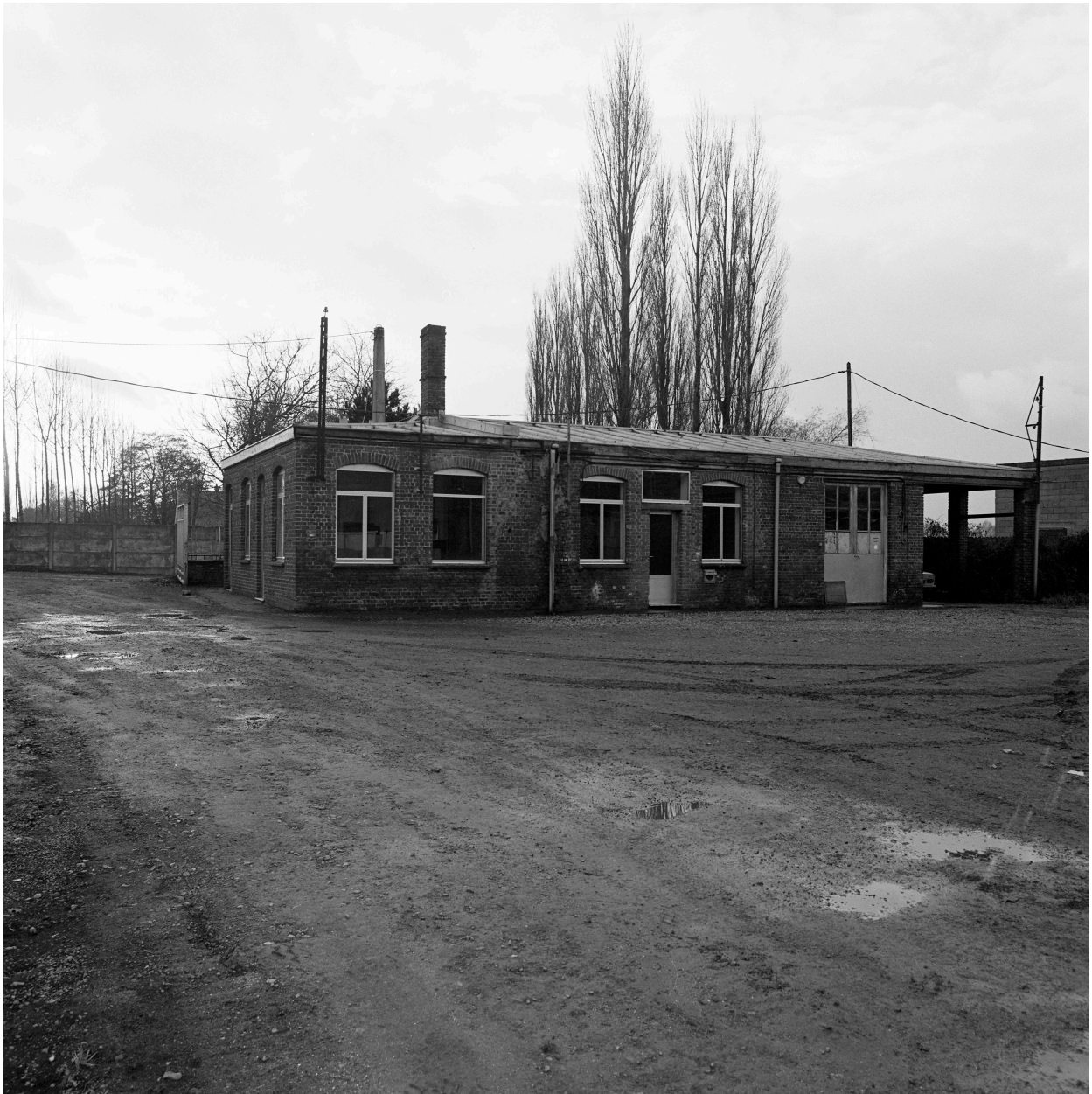
Bureaux et garage (H) depuis la cour, vue prise vers l'ouest.
