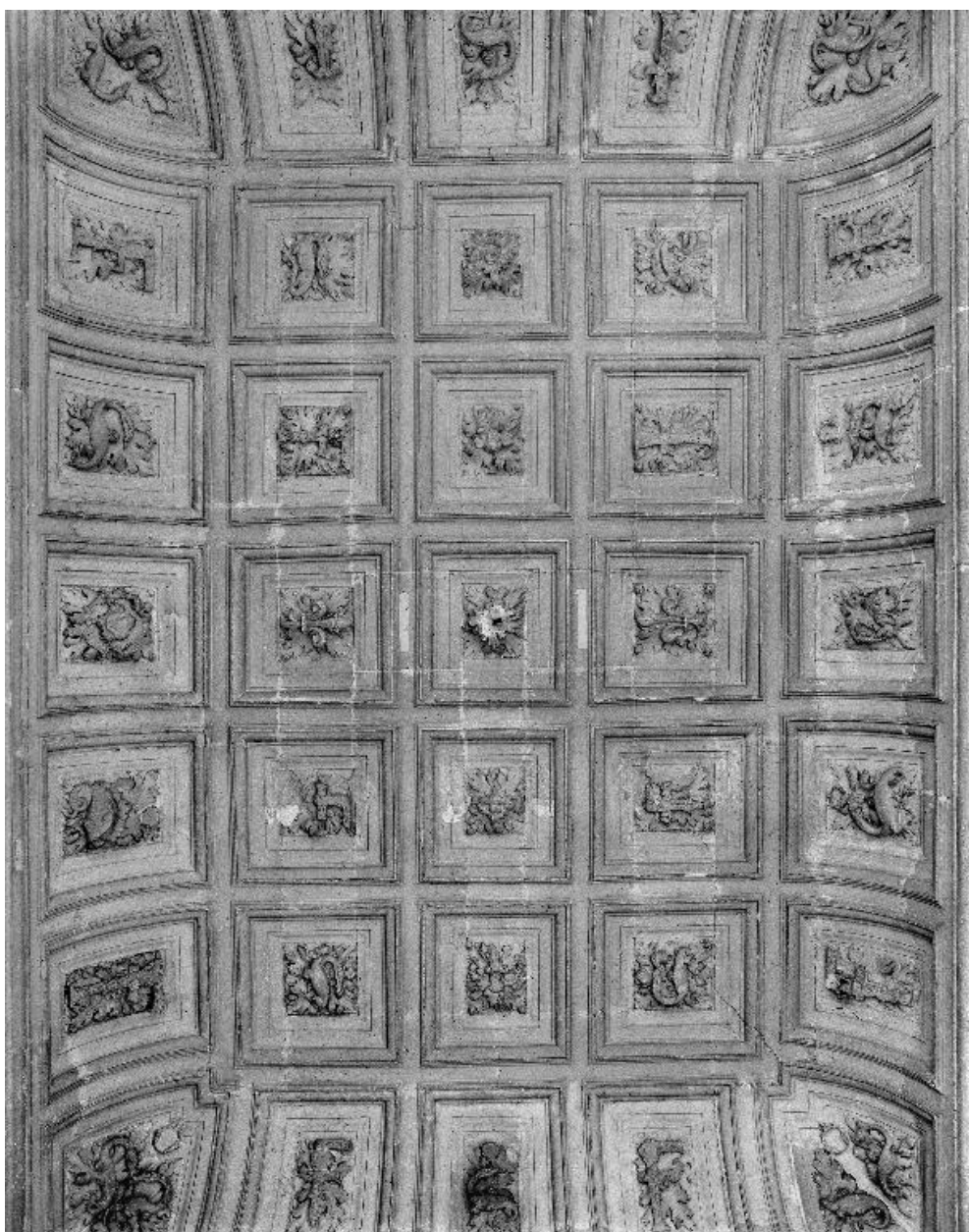
Vue générale de la voûte.
