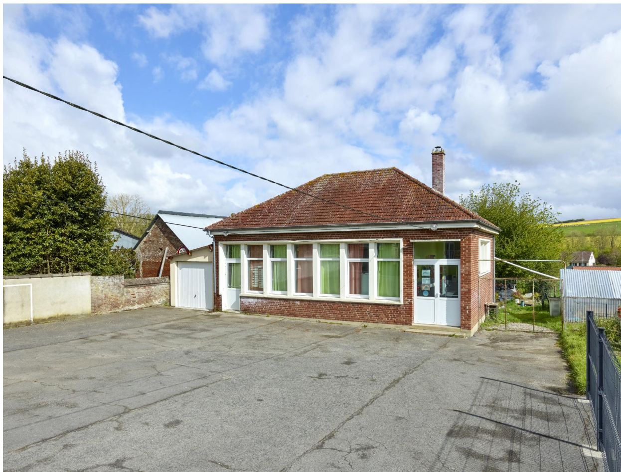
Vue de la salle de classe, depuis le sud.
