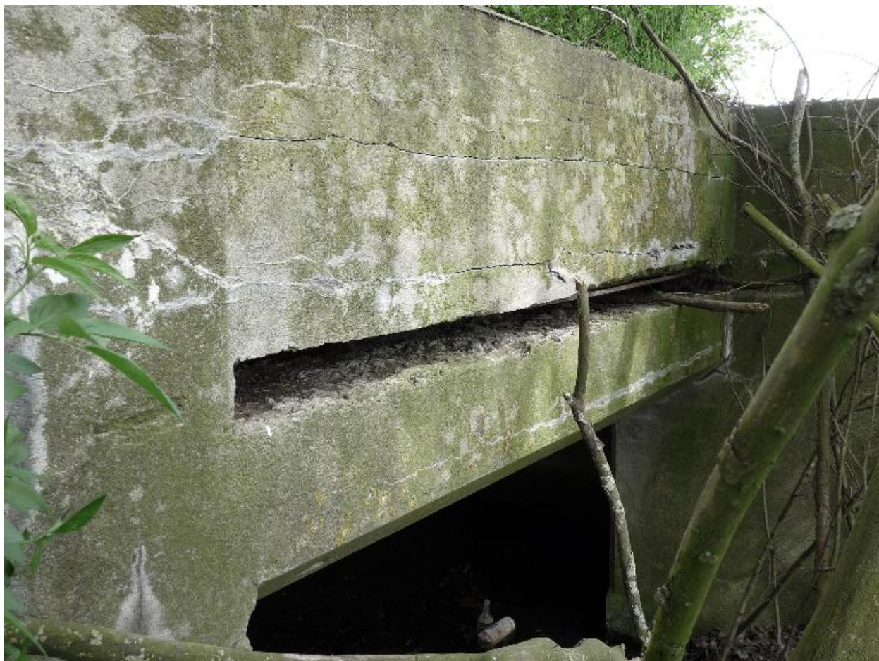
Elévation sud-est. Détail de la cellule d'éclatement
