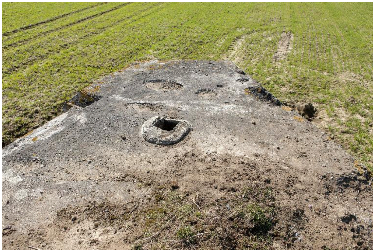
Couvrement, cheminée du périscopes
