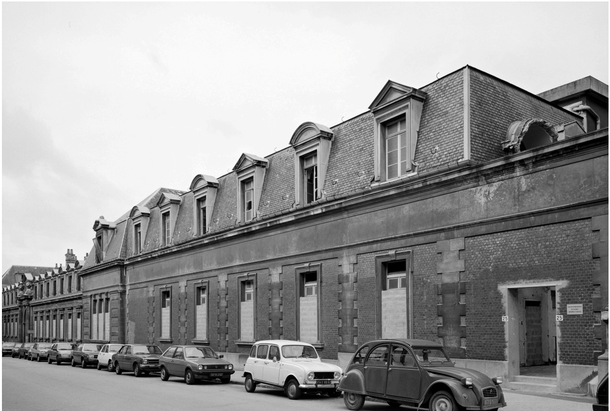
Bâtiment A, partie est, façade sur rue Saint-Louis.
