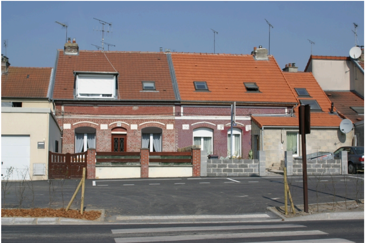
Façade d'un pavillon de la cité Dambrun.
