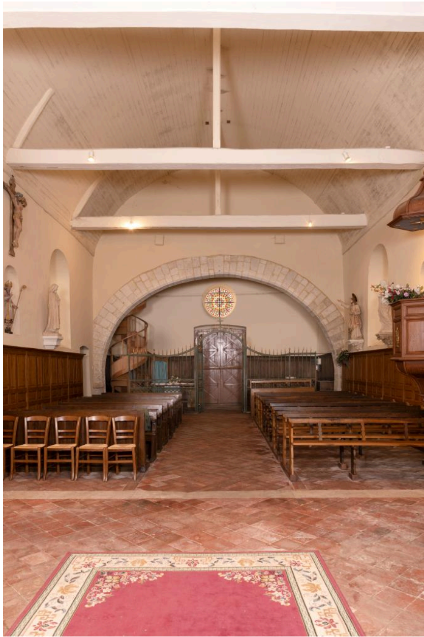
Vue intérieure vers la nef.
