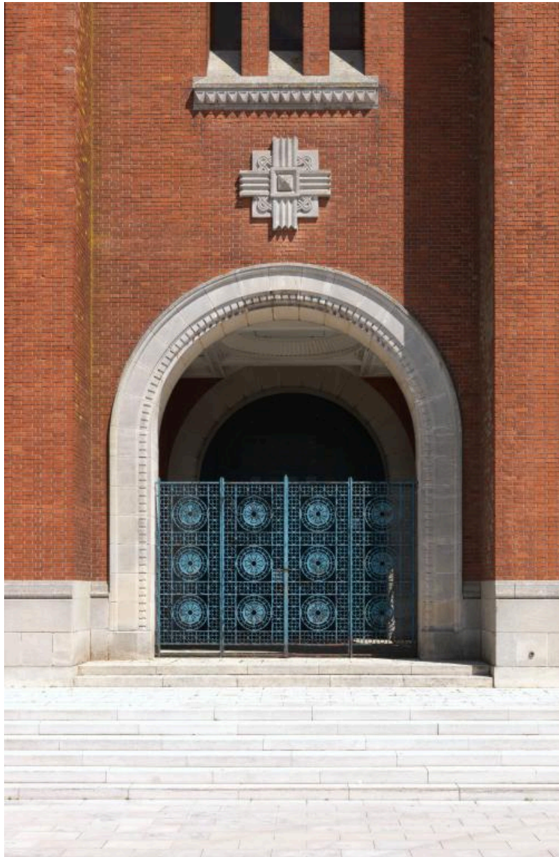
Vue du porche et de la grille, depuis le sud.
