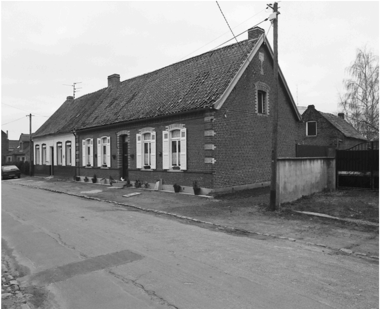
Maisons en alignement rue de la Chapelle.
