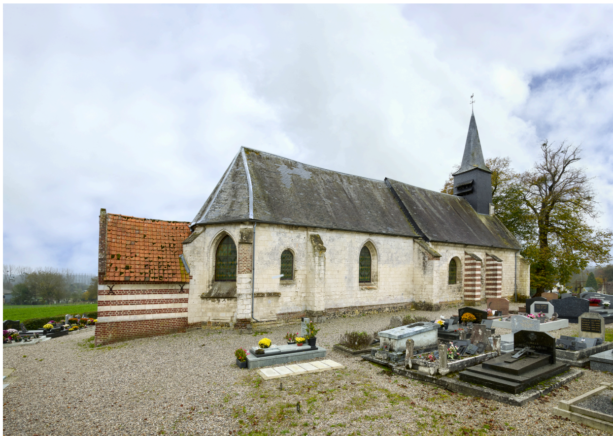
Vue de l'élévation nord.
