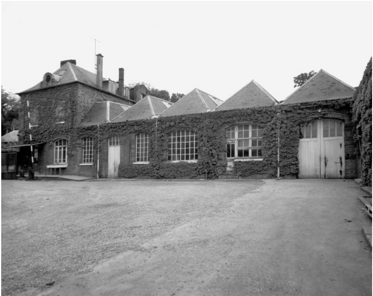
Tissage de jute. Vue d'ensemble sur cour de la conciergerie et de l'atelier de réparation attenant. Etat en 1988.
