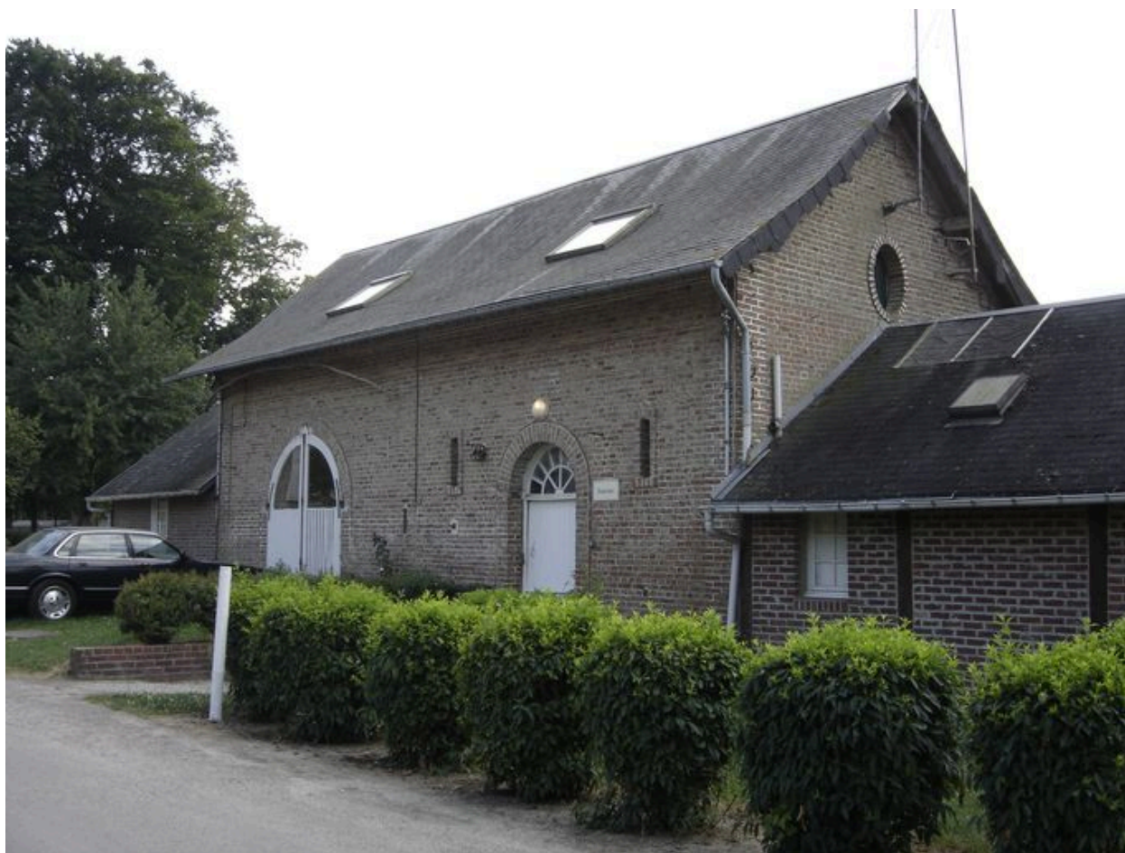
Vue de la grange.
