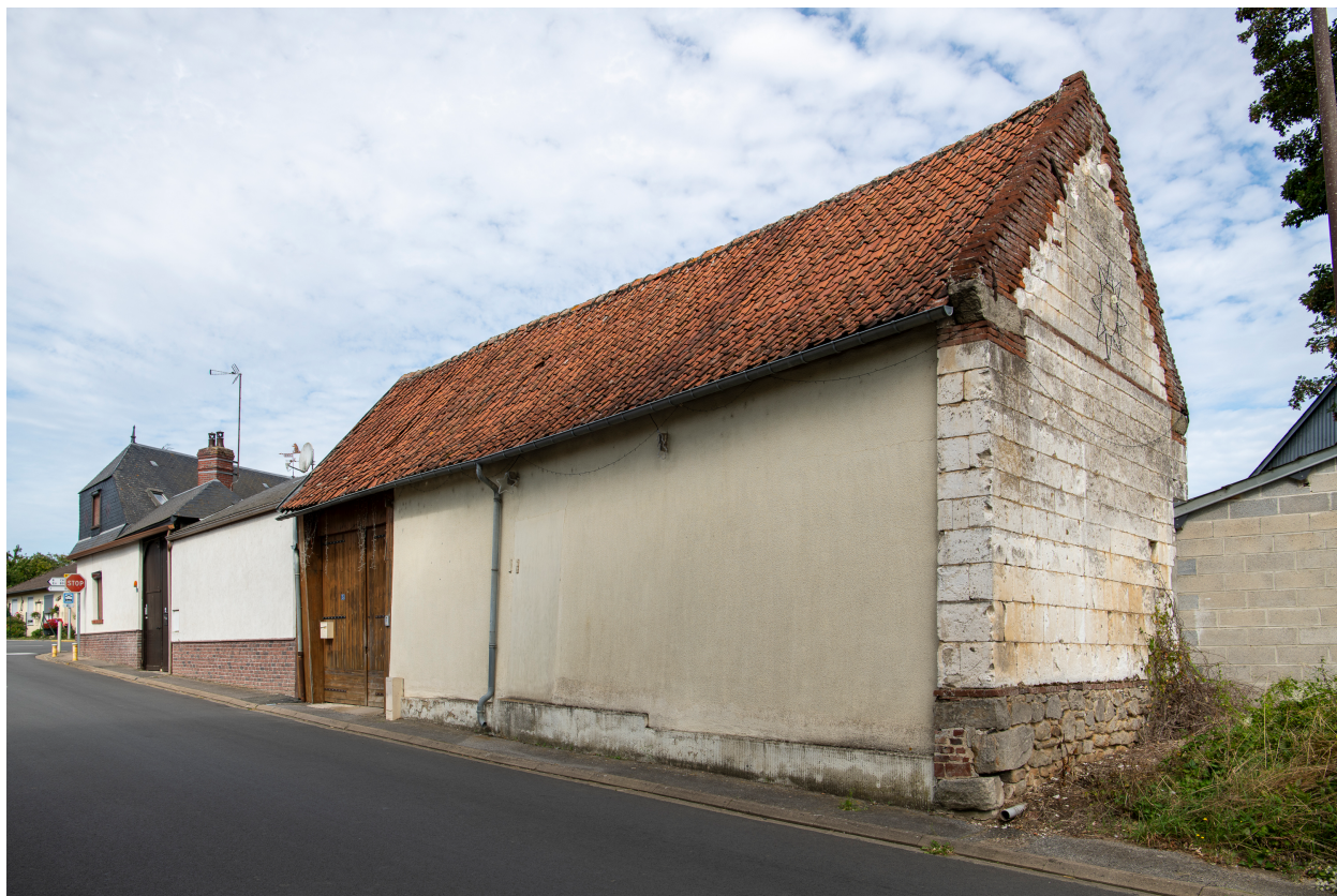
Grange sur rue avec pignon en pierre, n°3 de la rue Roland-Mariage, vue prise depuis le sud.
