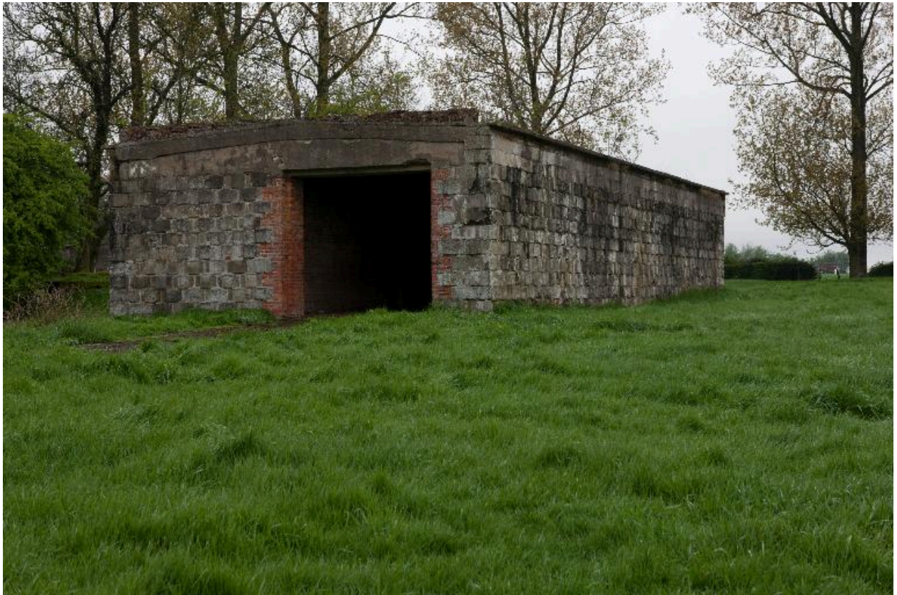
Bâtiment de montage. Vue générale prise depuis le sud-est.
