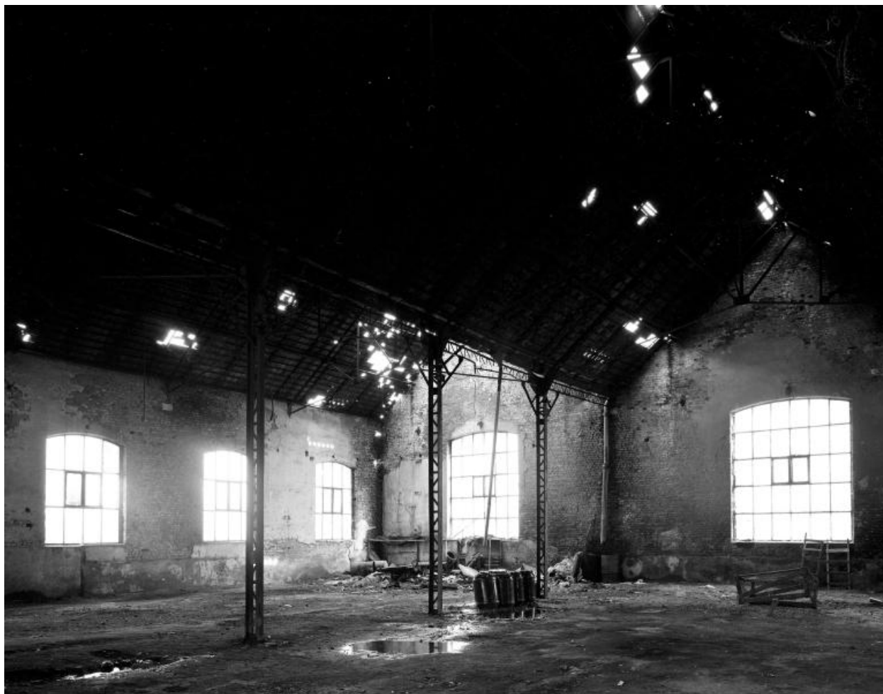
Remise ferroviaire, vue intérieure.
