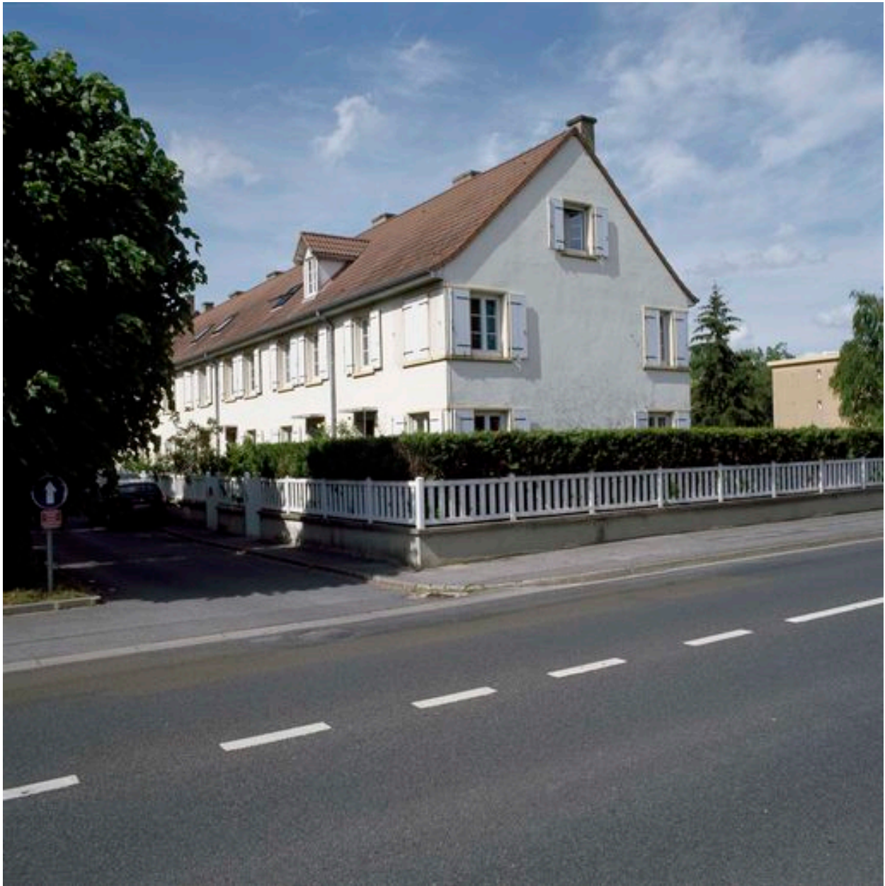
Vue d'un des immeubles à logements.
