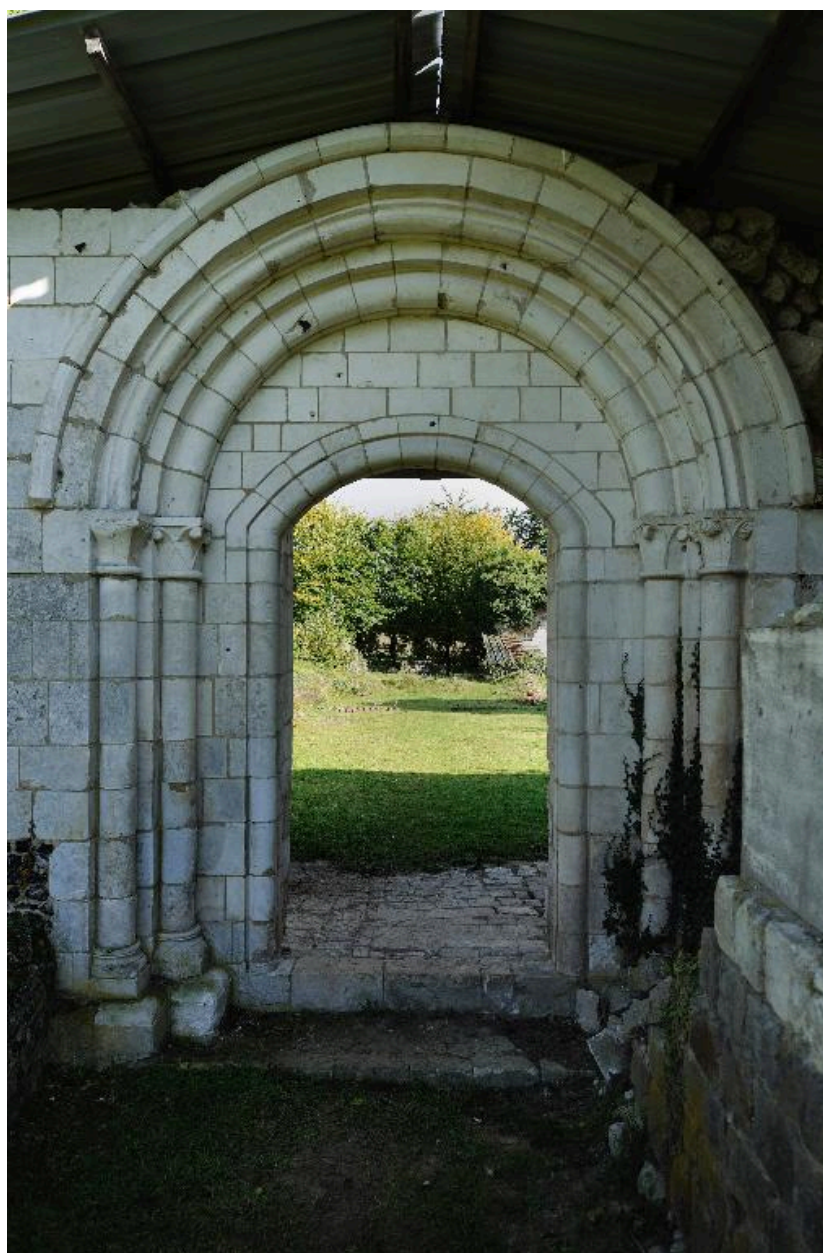
Portail occidental reconstitué de l'ancienne église priorale.
