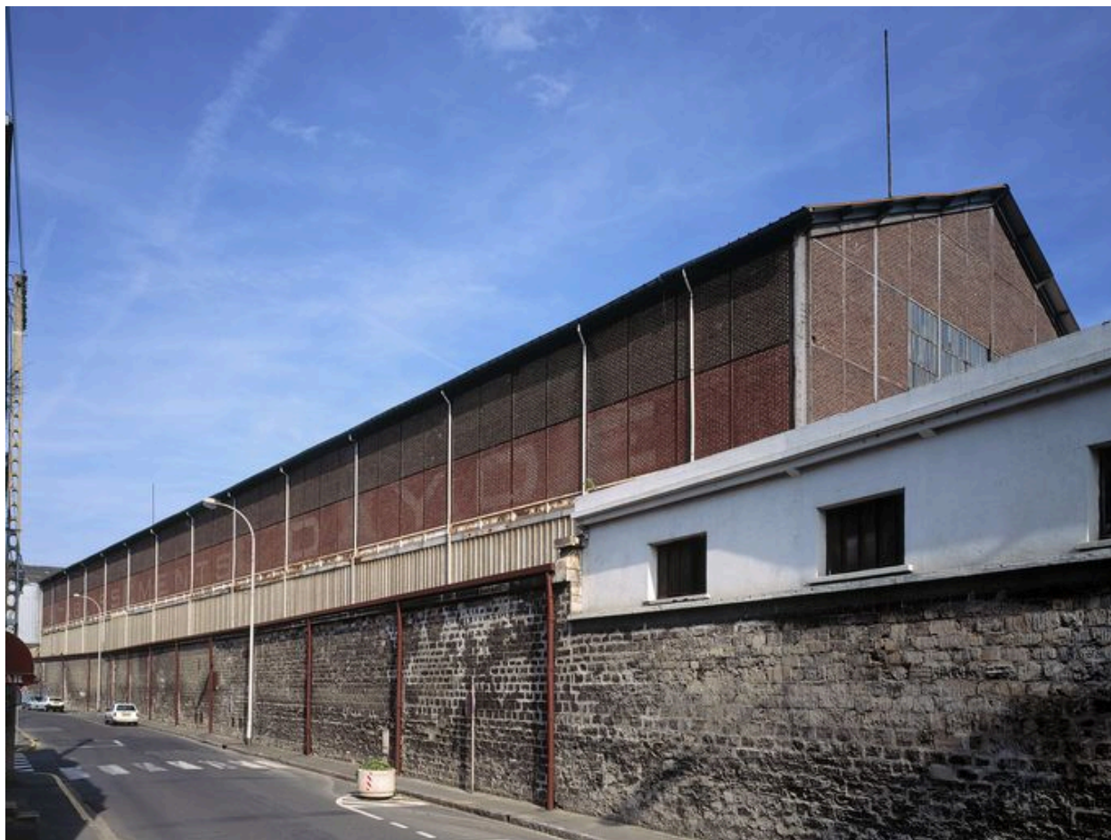
Halle de montage des ateliers Daydé-Pillé (Creil).
