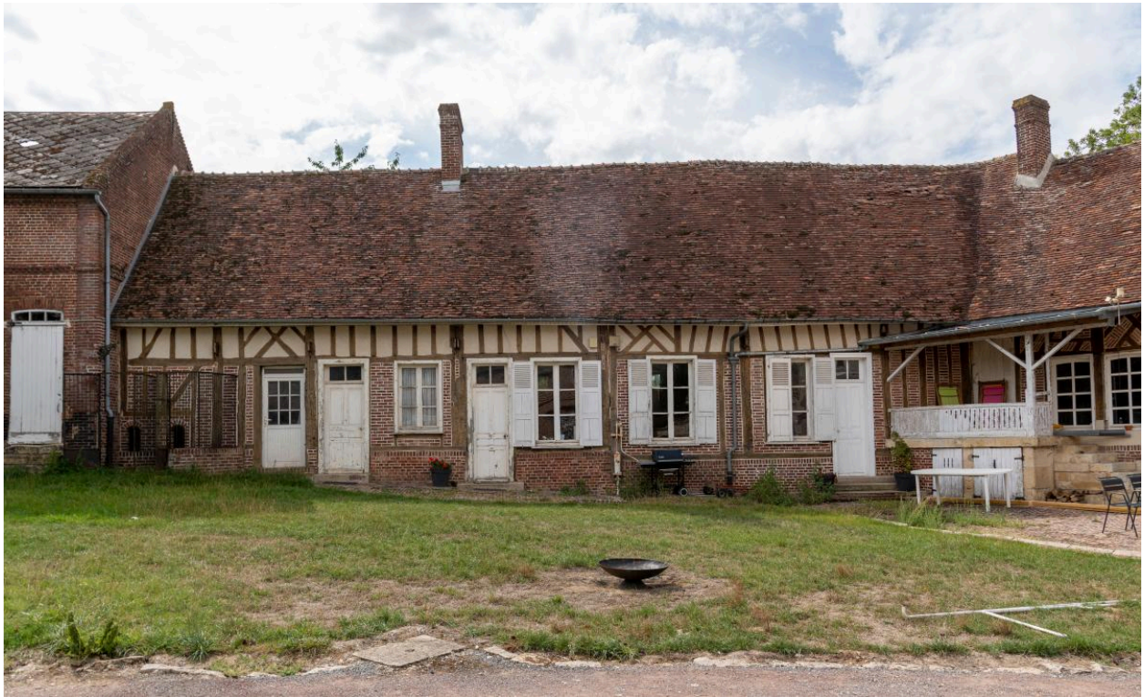
Ancien logement des bonnes, bûcher, poulains, vue depuis le nord.
