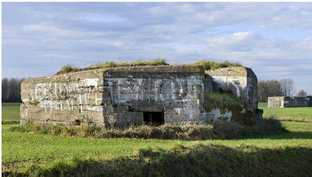
Vue générale, vers le nord. En arrière-plan, à droite, un édifice du même type (IA59004795)
