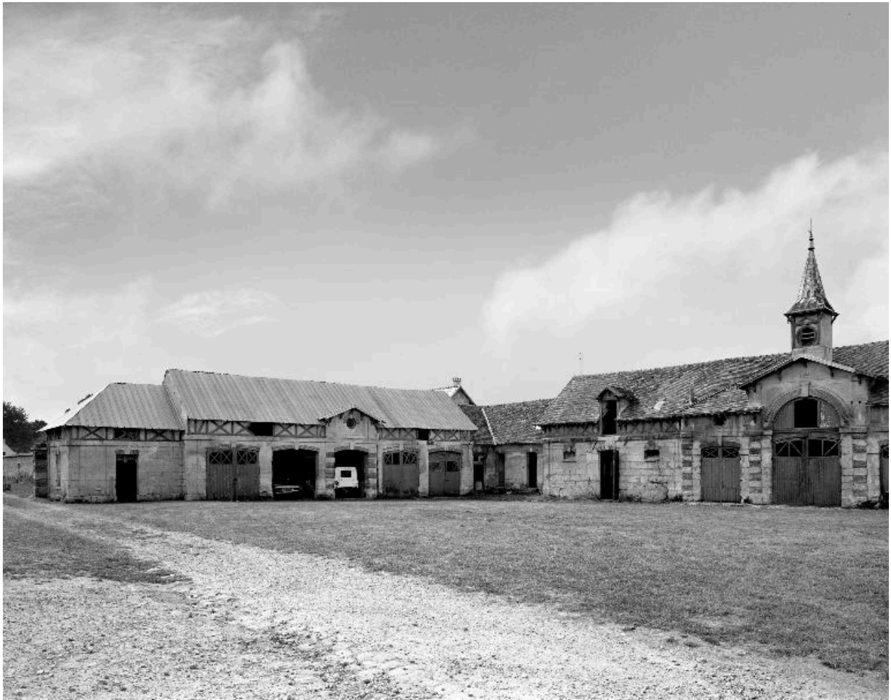
Vue partielle des communs depuis le nord.
