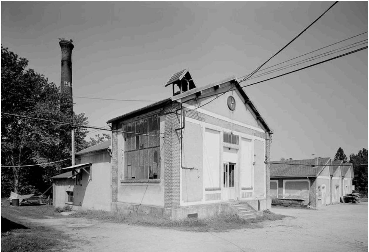
La chaufferie avec sa cheminée et les ateliers en shed à l'arrière plan.
