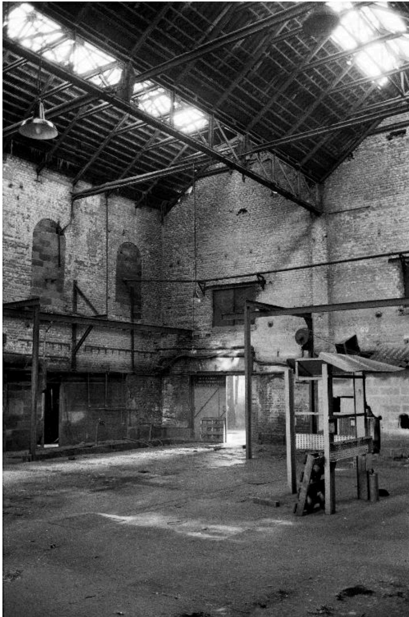
Salle des machines, vue intérieure.
