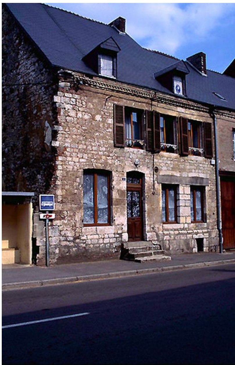
Vue de l'élévation sur rue du n°4.
