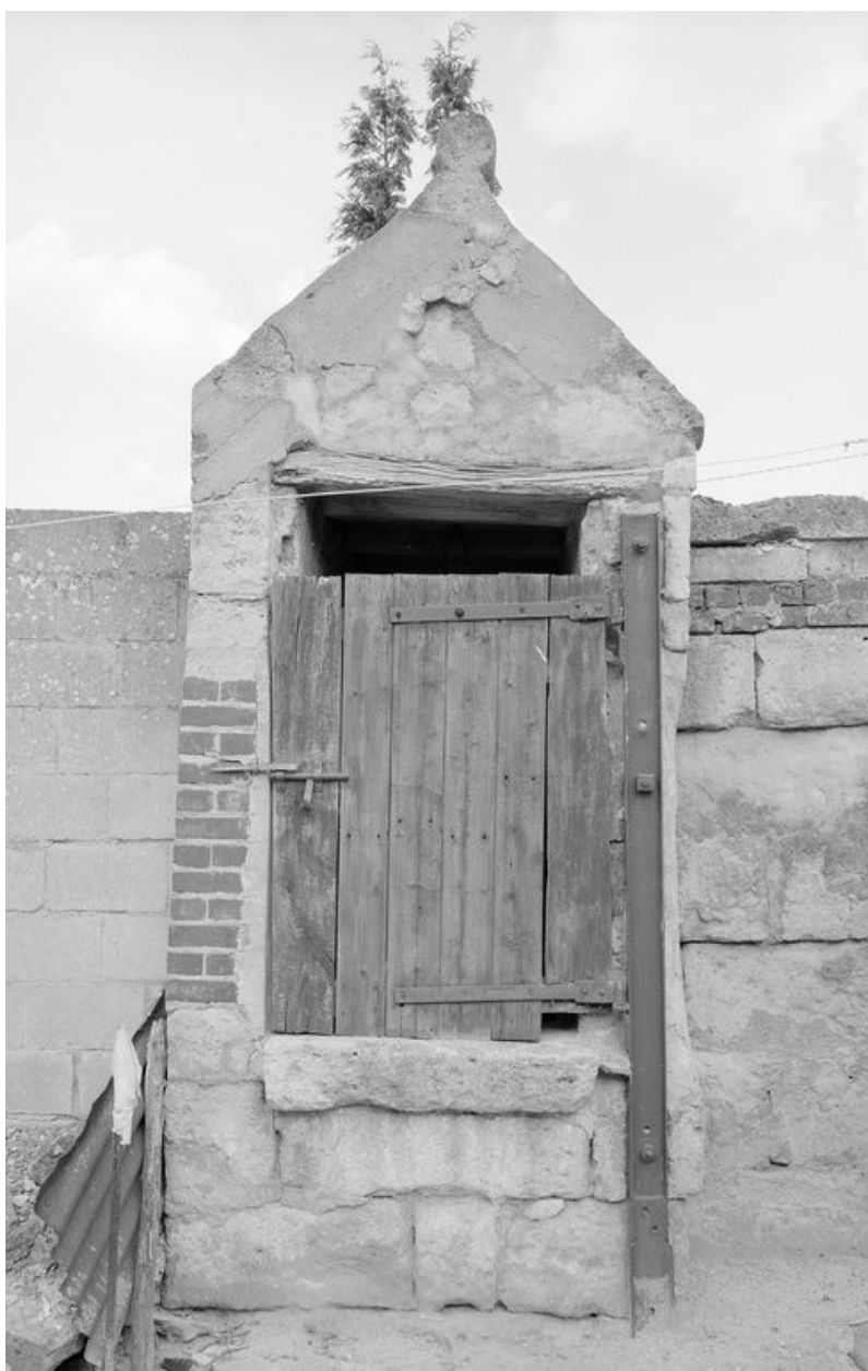
CUTS. Puits d'une ferme repérée.
