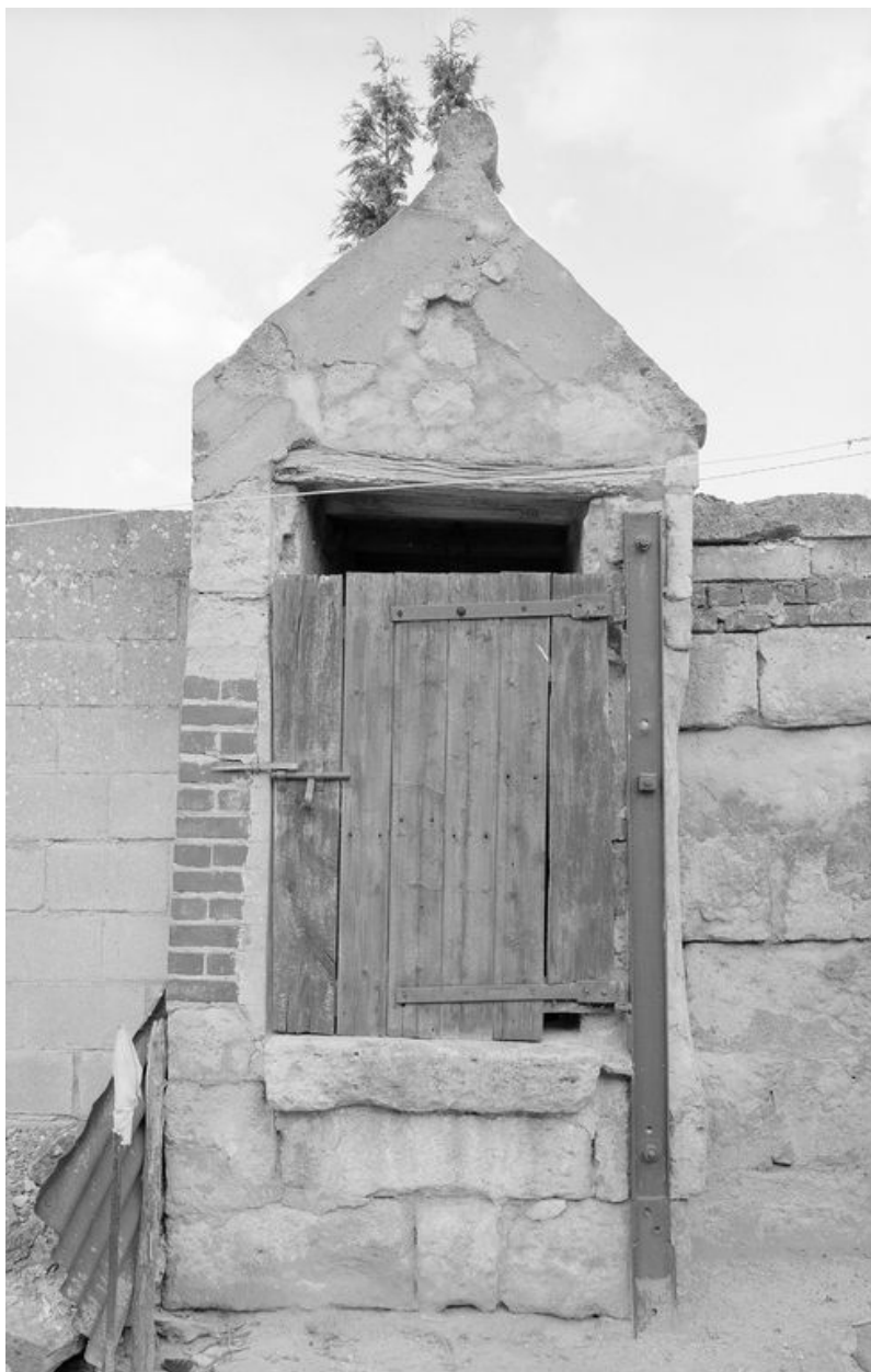
CUTS. Puits d'une ferme repérée.
