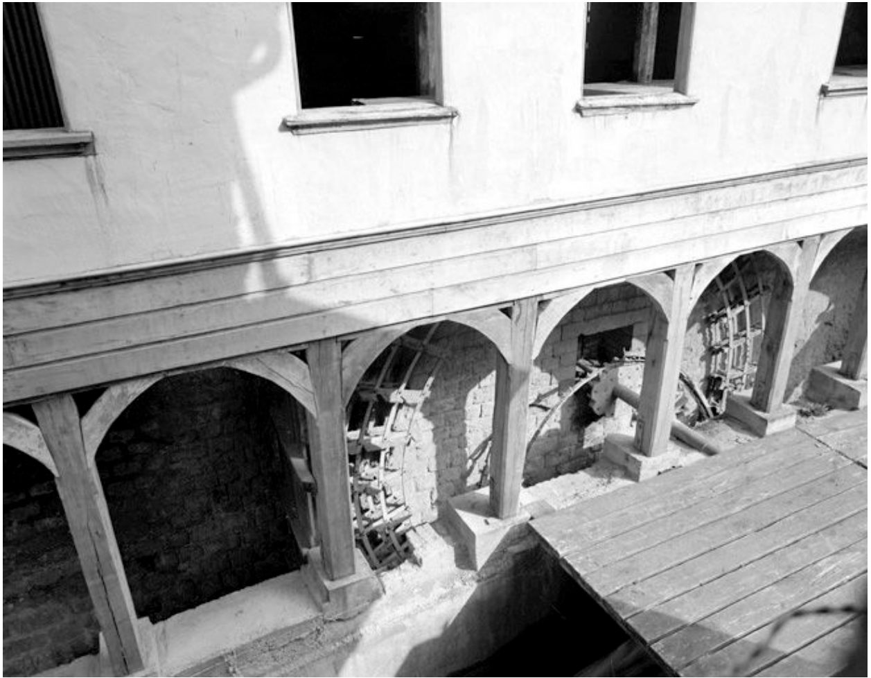
Coursier et roue hydraulique.
