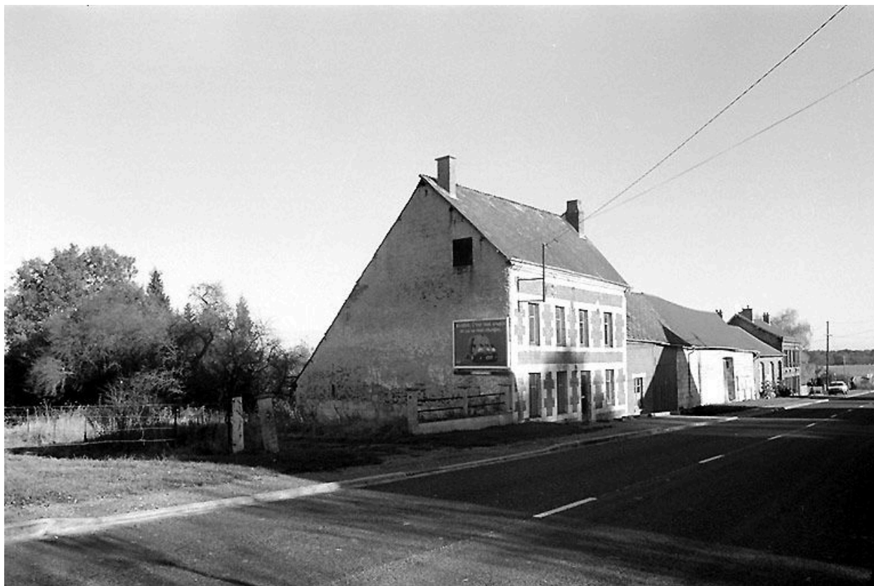
Vue générale : logis et grange depuis le sud-ouest.
