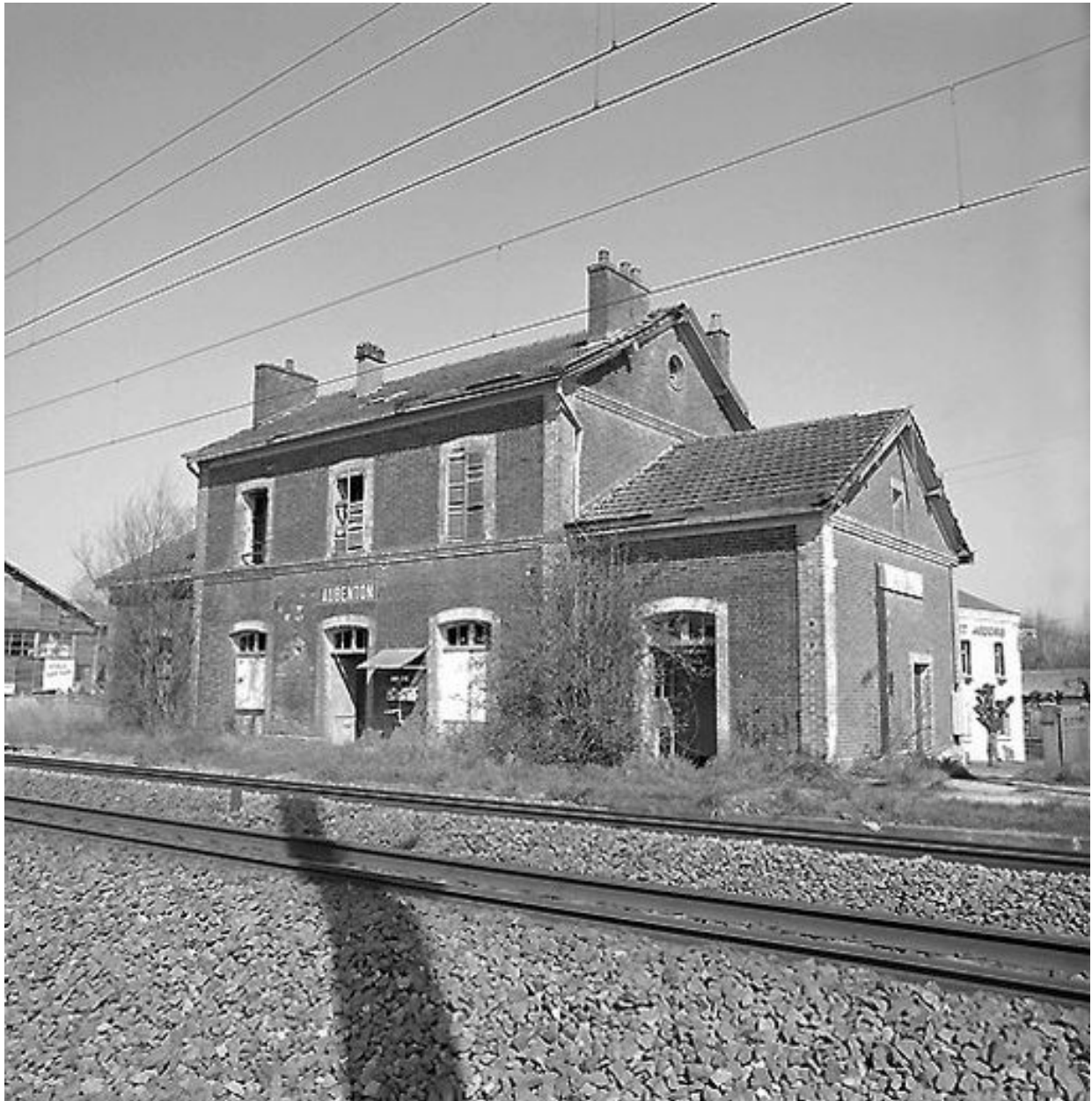
Élévation postérieure depuis la voie.
